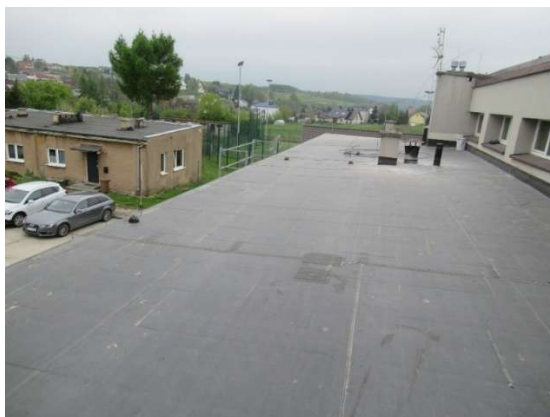
Remont pokrycia dachu Sali gimnastycznej w SP Nr 1 w Skale
