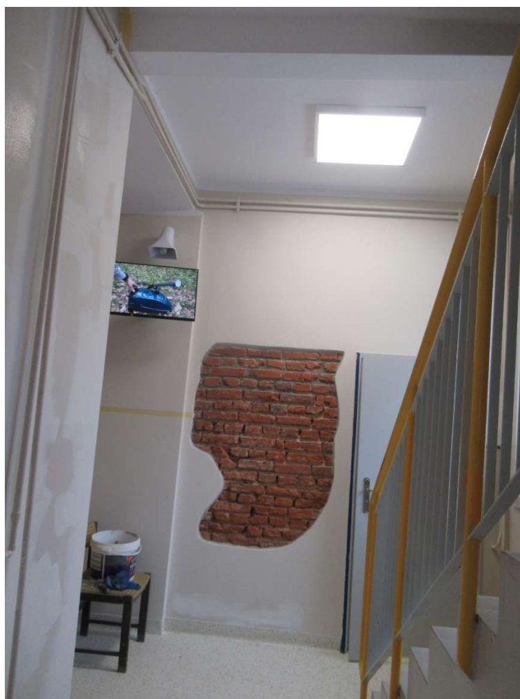
Remont korytarza w SP w Smardzowicach
