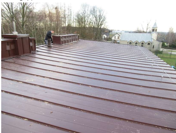
Remont dachu w SP w Szczodrkowicach
