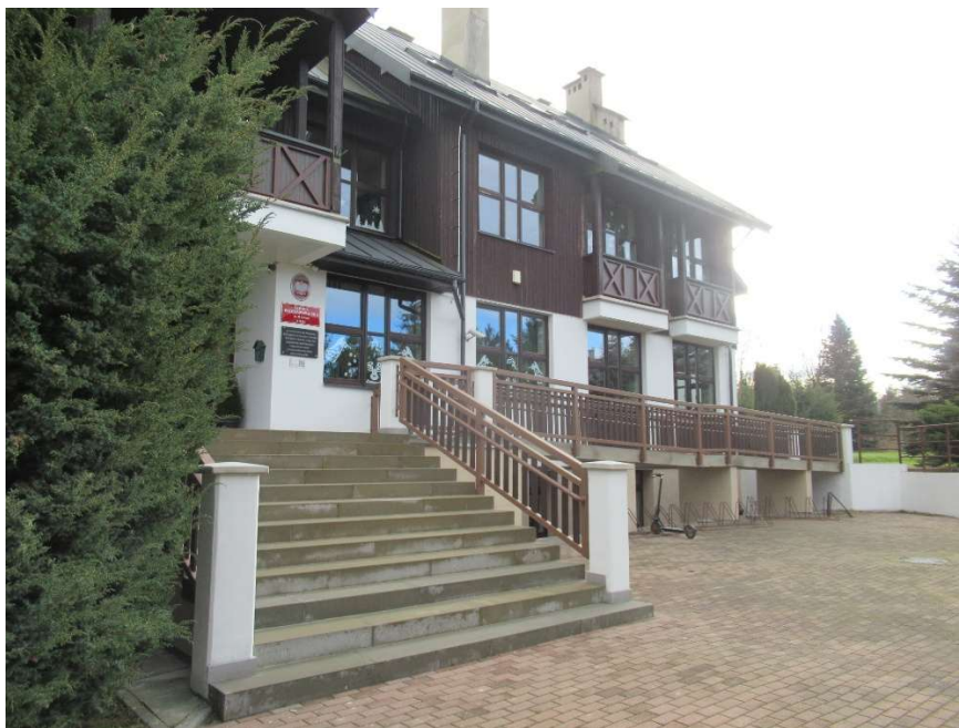
Remont elewacji, schodów w SP Nr 2 w Skale
