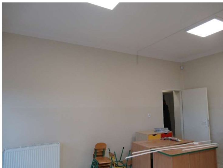
Remont pomieszczeń sali w SP w Smardzowicach
