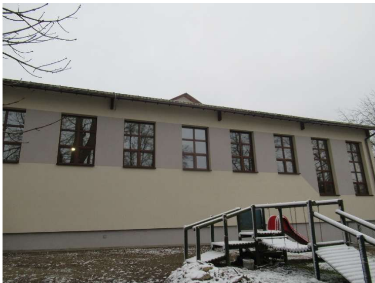
Remont elewacji Sali gimnastycznej w SP w Cianowicach
